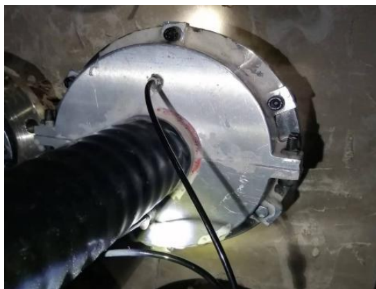
图 6 封堵安装
